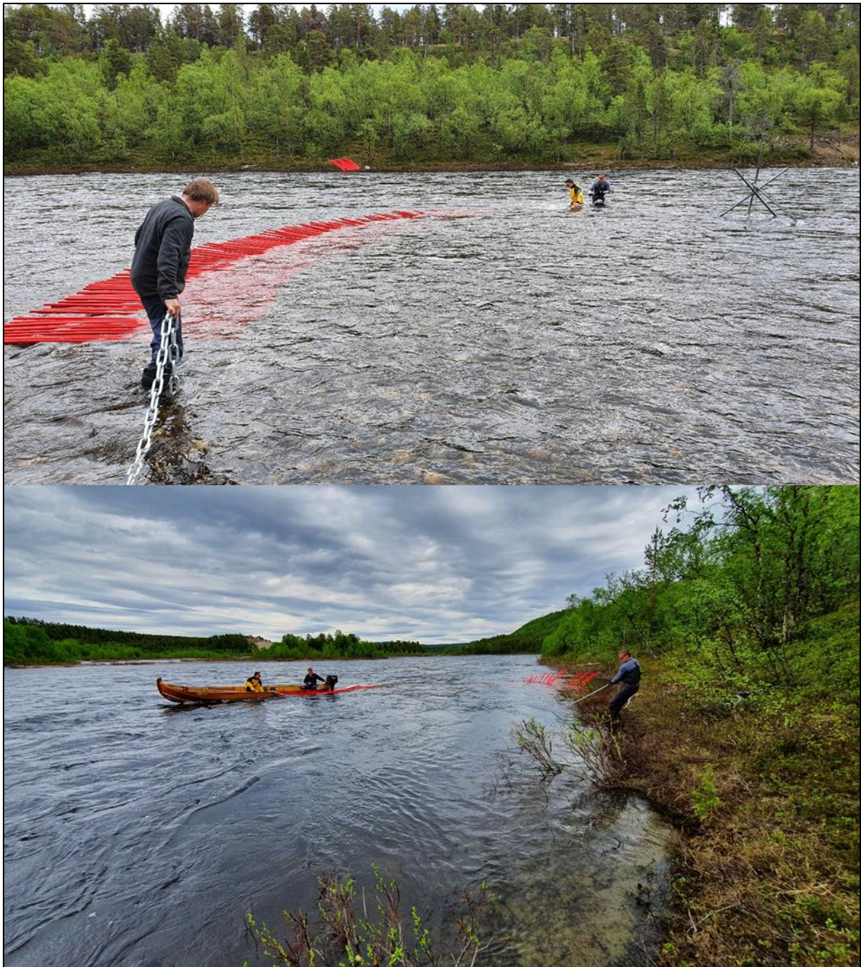
Figur 6: Utplassering av ledegjerde bestående av luftfylte røde veistikker som er festet til en vaier og kjetting på bunnen. De ble dessuten festet til flere større lodd. Gjerdene kunne dras ut for hånd på sonarsiden av elva (øverst), og kunne lettvind justeres i løpet av sommeren. På motsatt side av elven (nederst) ble ledegjerdet plassert ut med båt og man er avhengig av båt for å justere gjerdet gjennom sommeren.
