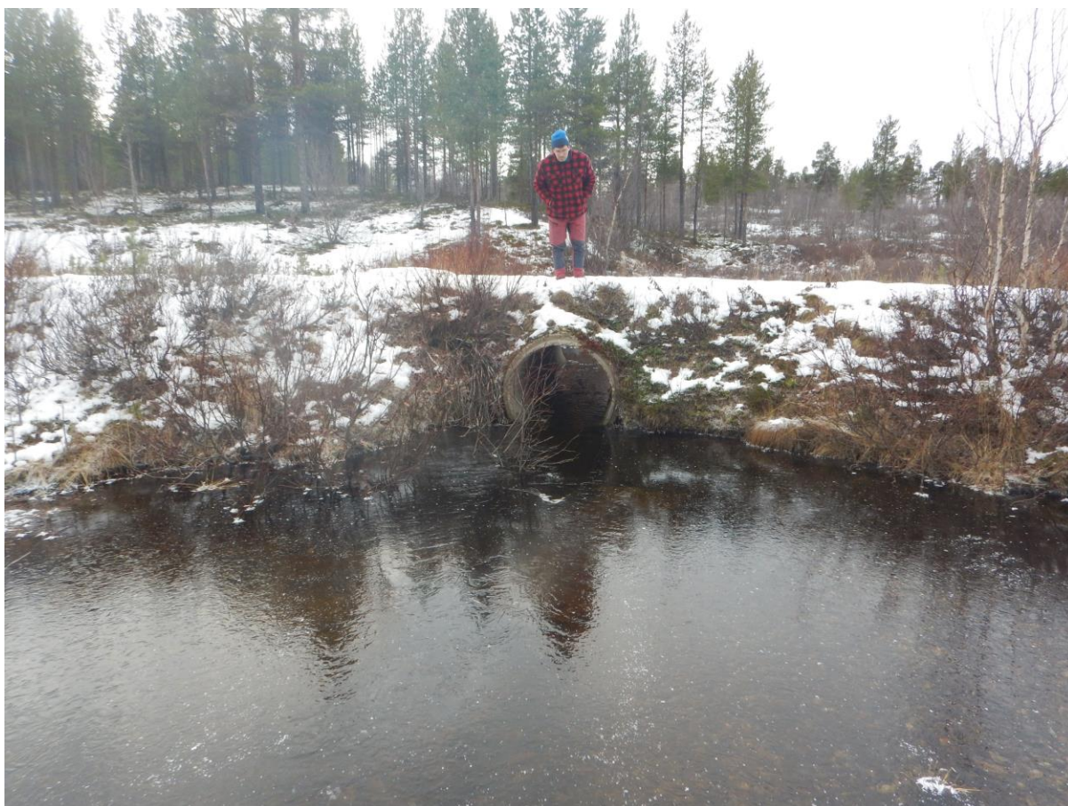
Bilde 6: vannrett rørkulvert i Geassesaiája med lav strømhastighet og naturlig elvesubstrat i bunn er passerbar for ungfisk. Dette kan være en grei alternativ løsning for Ráitejohka.
