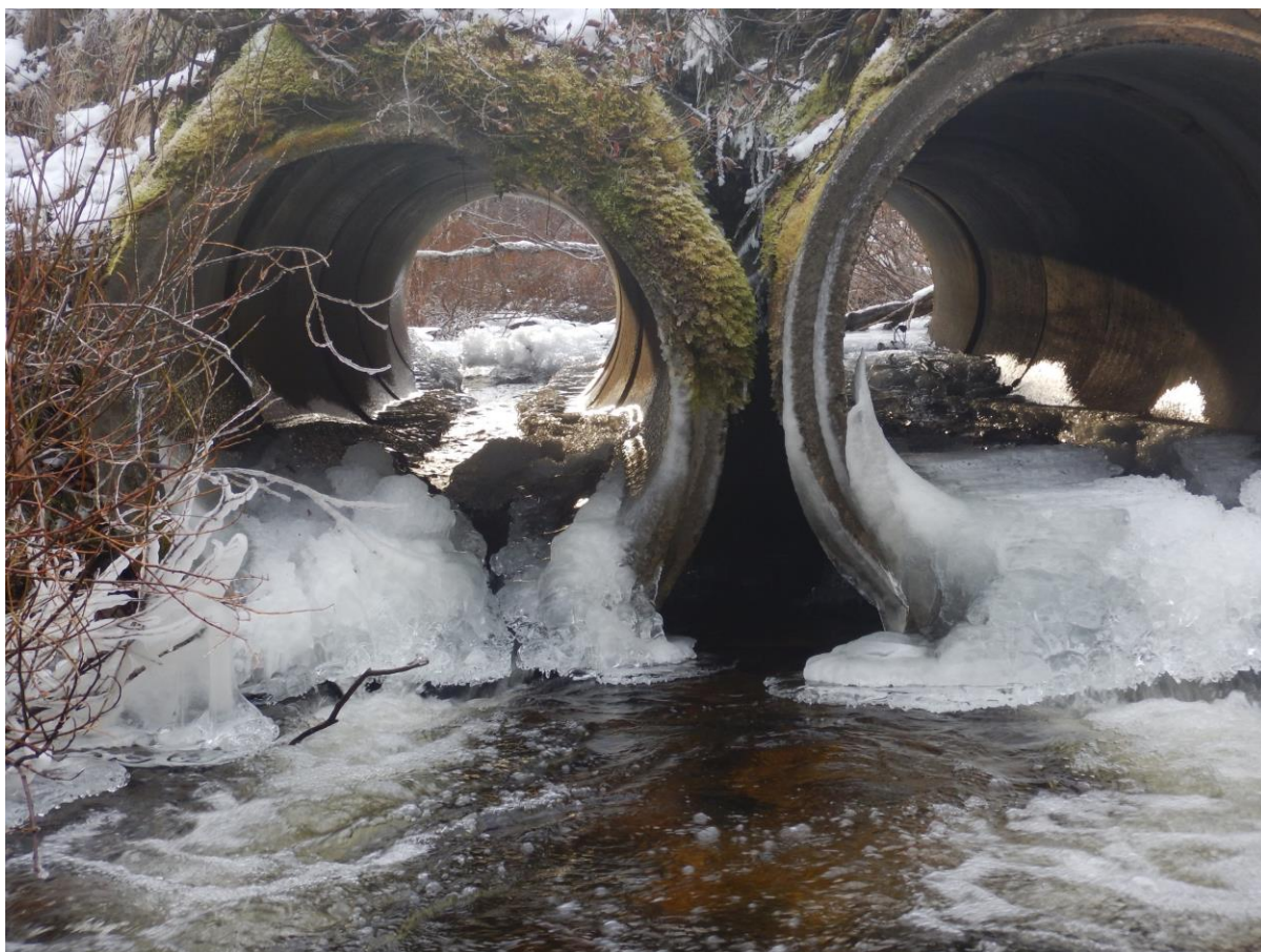
Bilde 3, viser rørkulvert under veien over Ráitejohka.
