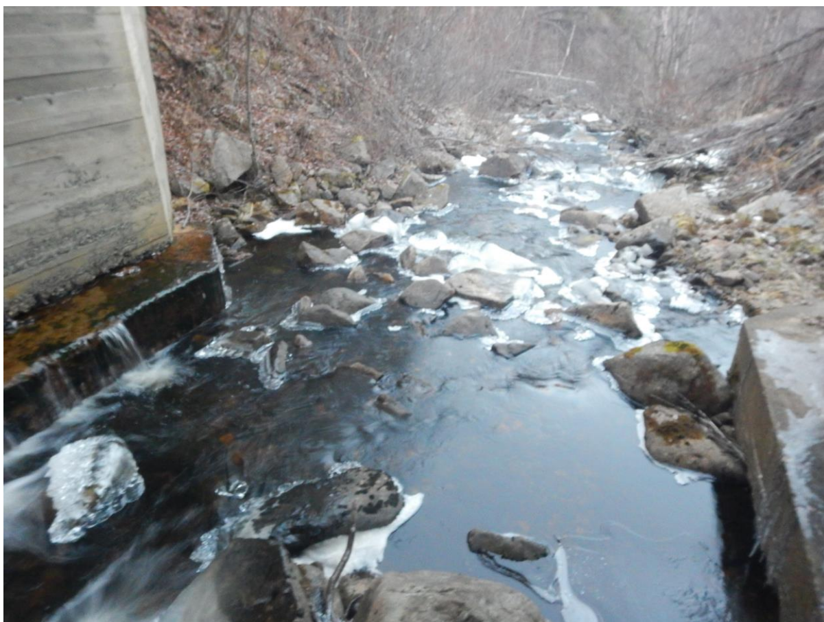
Bilde 2 viser bunnstruktur av brua over Vuolit Ruovttujohka som beholder en naturlig elvebunn. En slik løsning hadde vært den mest ideelle for Čáhppesjohka.
