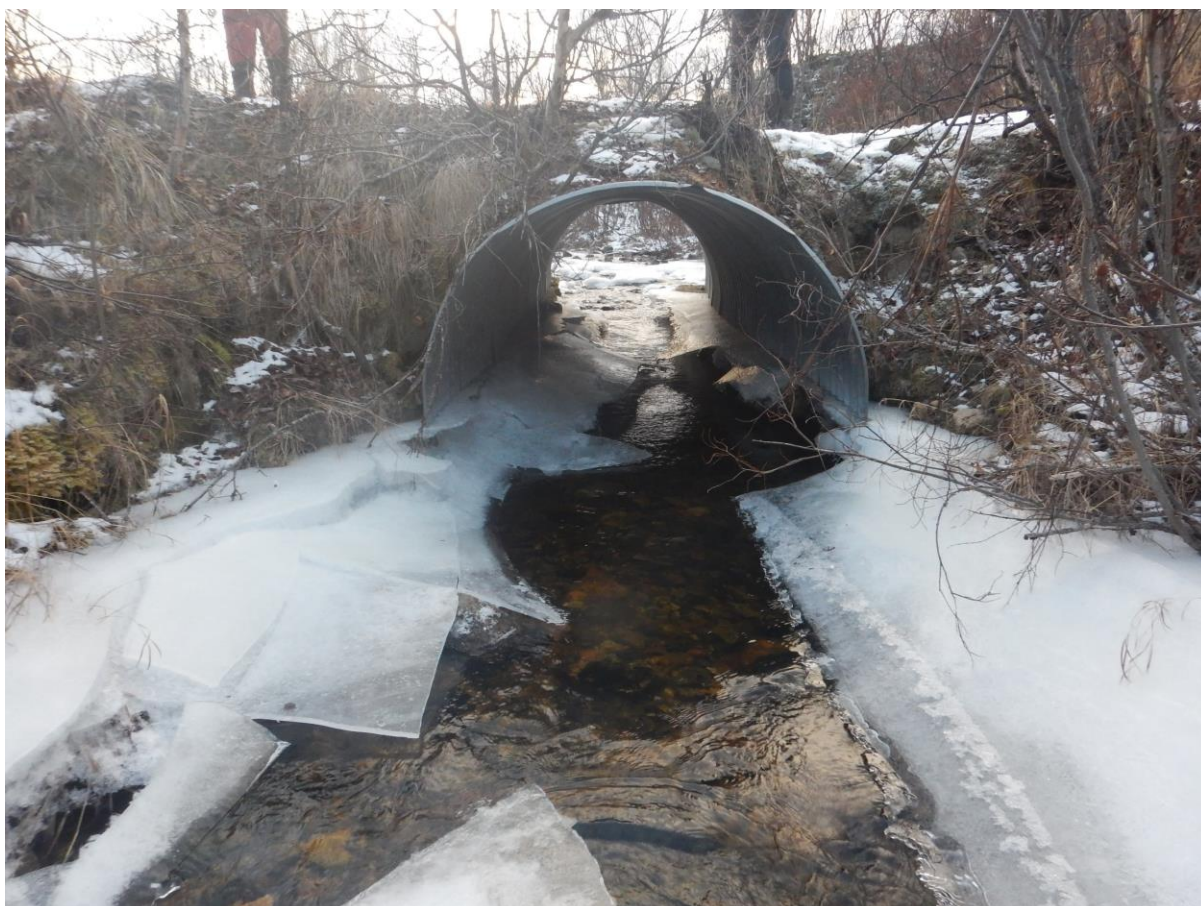
Bilde 5: hvelvkulvert i Njáhasjohka. Muligens kan dette være en helrør fult opp med grus og stein. Her er målet om naturlig bunnsstrat, ideelt for vandringen av ungfisk, oppnådd på eksemplarisk vis.
