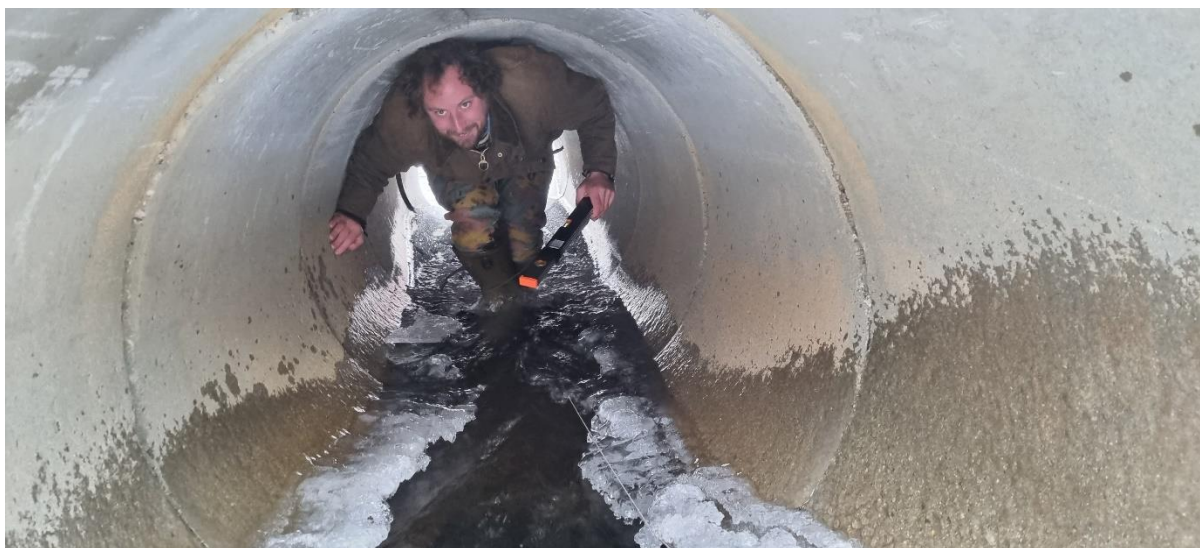
Pierre undersøker stikkrenne i bekkefelt tilhørende Anárjohka. Foto: Sonja Kimo Pedersen.
