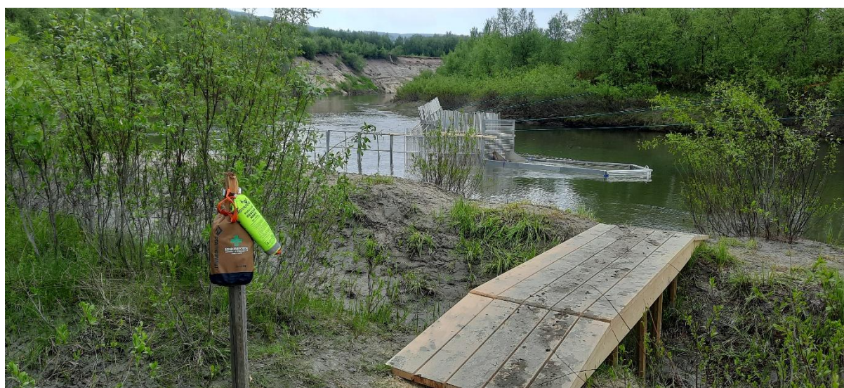
Bilde 1 illustrerer at det ble tatt et visst hensyn til sikkerhet. Bildet ble tatt under installasjon av fellen der de siste spilene (P.E. rør) skulle på plass.
