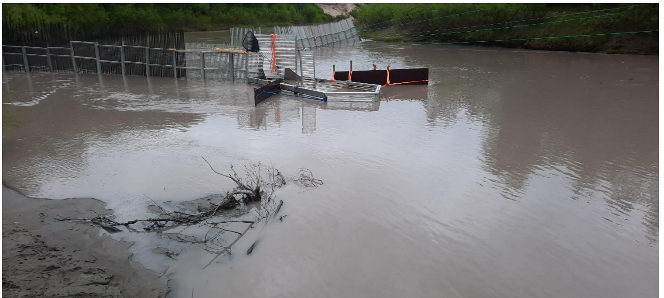
Bildet 2 viser spilefellen i sin helhet med stømforsterkende anlegg med kryssfinérplater på både innsiden og utsiden av fangstkammeret, det V-formede ledegjerdet, utvandringspassasjer på hver side og forsterkninger mot land. Bildet ble tatt rett etter åpning av fellen, etter den var stengt ifm. leirras.
