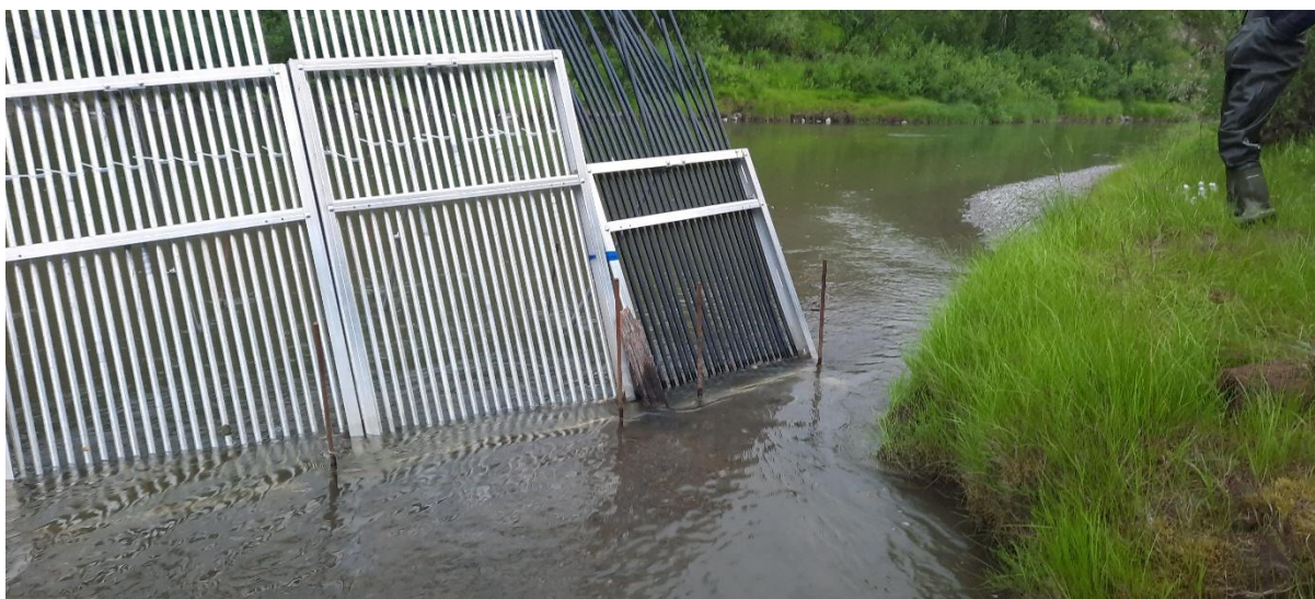
Bildet 7 viser en av to nedvandringssløsning på utsiden av ledegjerdet.
