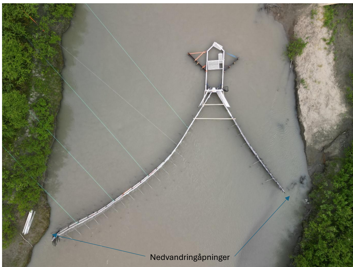
Bilder 6 viser fella i sin helhet, med nedvandringssløsninger på begge sidene av ledegjerdet.
