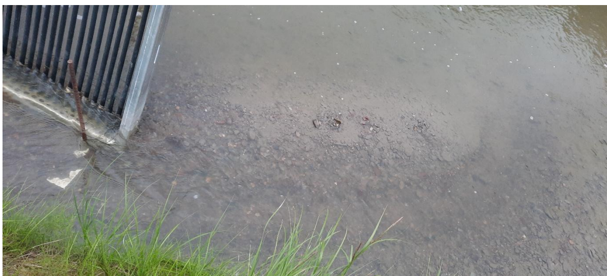
Bildet 8 viser den dypere «kanalen» ved nedvandringssløsning for å tillate fiskene vandring gjennom det grunnere parti. Minst dybde på lav vannføring var på ca. 30 cm.
